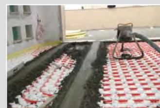
Για τους λόγους αυτούς η παρασκευή και η χύτευσή του πρέπει να τηρεί ορισμένους κανόνες που είναι πολύ σημαντικοί για την καλή λειτουργία και απόδοση του συστήματος. Σε καμία περίπτωση το θερμομπετόν δεν αποτελεί ένα απλό κονιόδεμα χωροστάθμισης.
