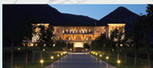
Οινοποιείο Κτήμα Βιβλία Χώρα, Κοκκινόχωρι Καβάλας
